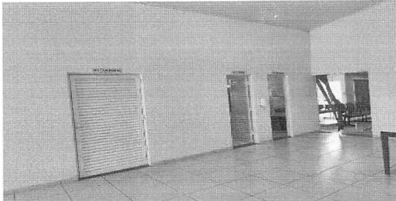
Vista de acesso aos banheiros e interno dos banheiros, portas de alumínio com divisórias de mármore, revestimento nas paredes todo de cerâmica
