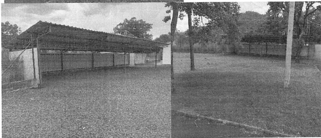
Garagem para 06 veículos, coberta
