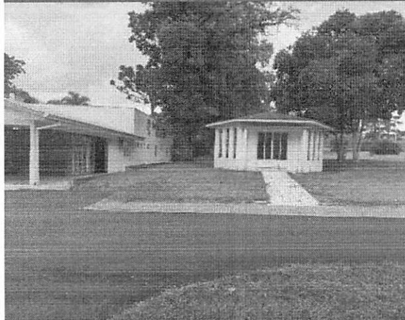
Fachada da Capela, medindo 30m 2
