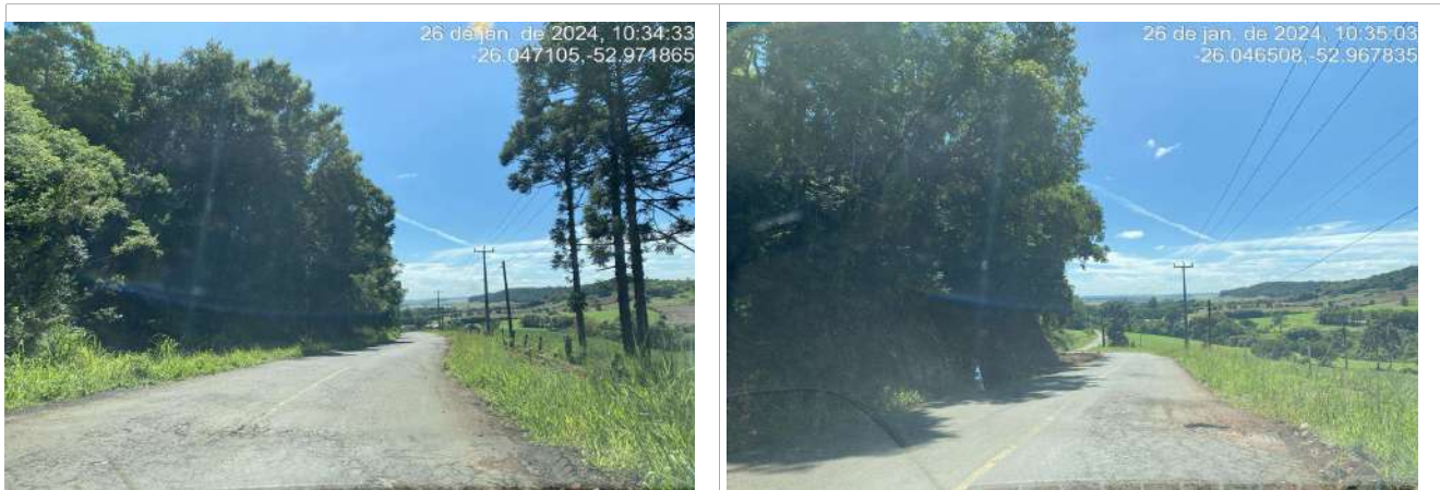
Estrada Vicinal a ser recuperada. Estrada Vicinal a ser recuperada. Trecho de correção de curva já executado.
