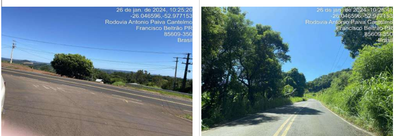
Intersecção com a rodovia PR-566 Estrada Vicinal a ser recuperada.
