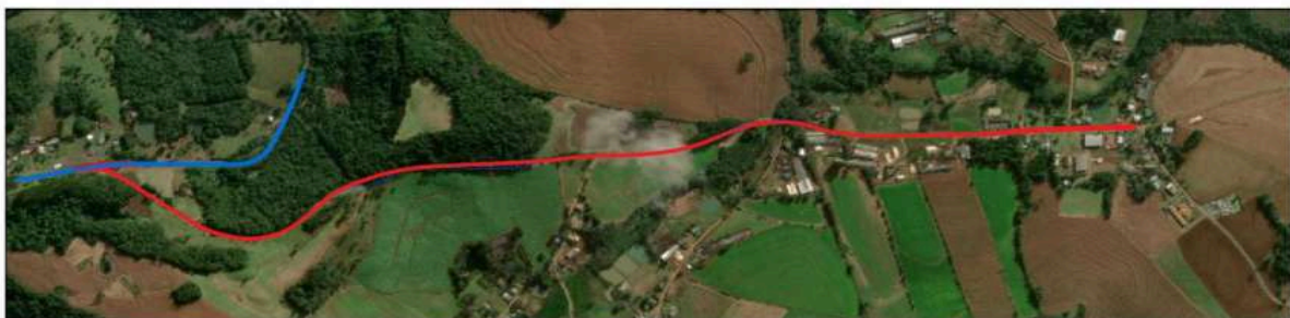
Figura 2: Trecho a ser pavimentado.
