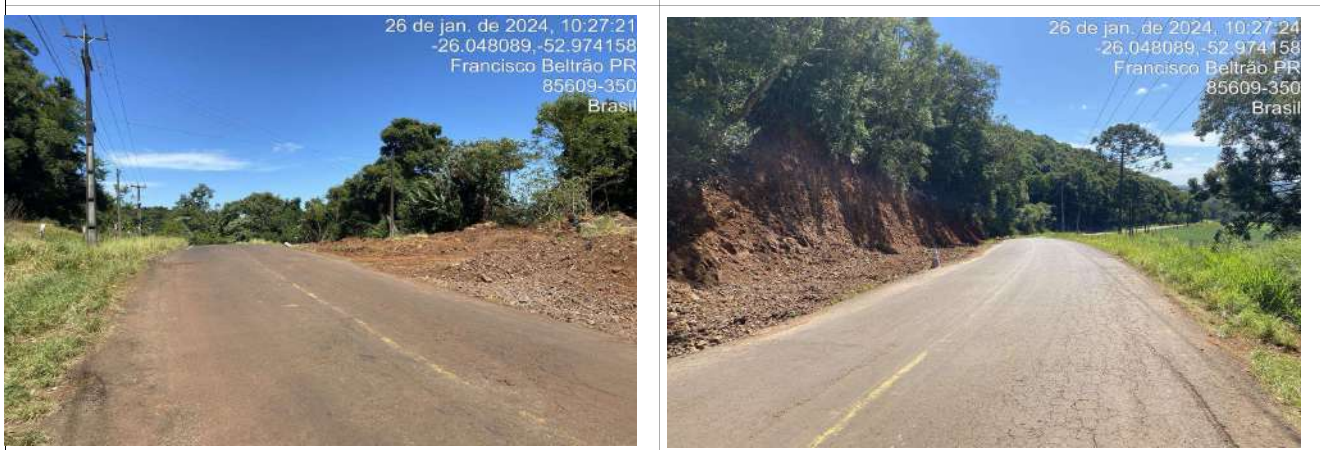
Estrada Vicinal a ser recuperada. Trecho de correção de curva já executado. Estrada Vicinal a ser recuperada. Trecho de correção de curva já executado.
