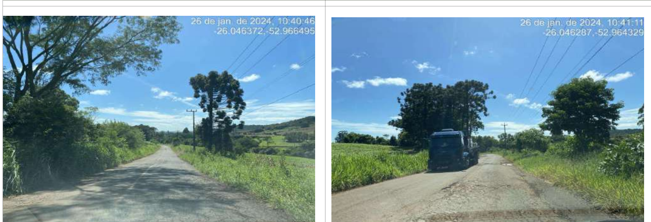
Estrada Vicinal a ser recuperada. Estrada Vicinal a ser recuperada.
