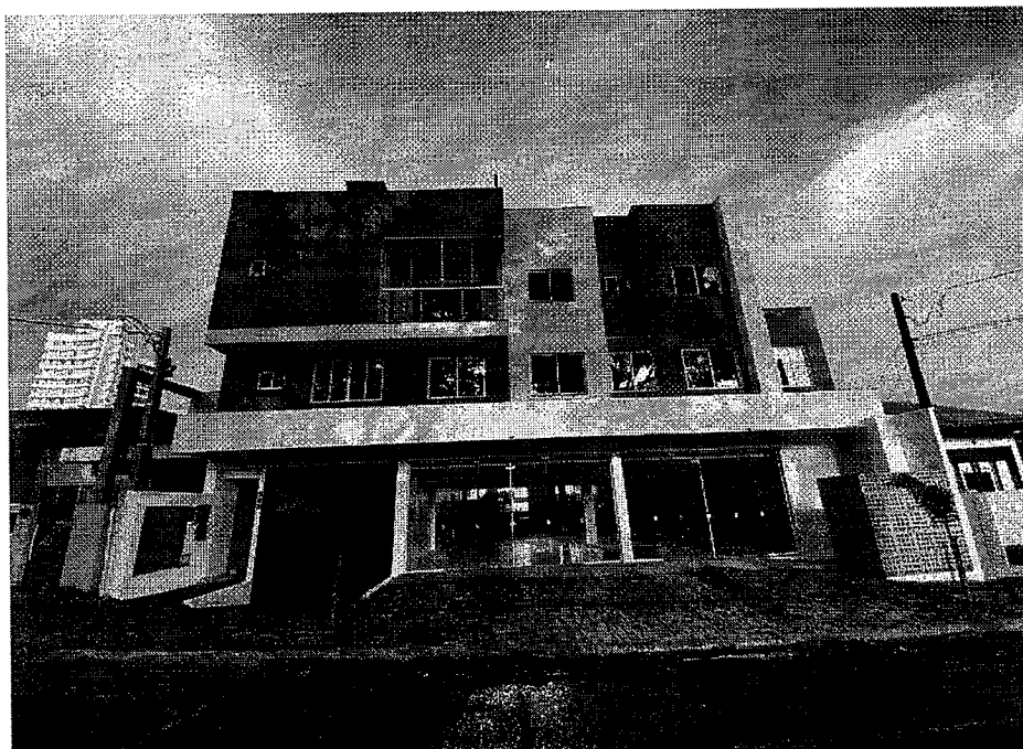
Vista da fachada frontal do imóvel. (Fonte: Autor, 2022).
