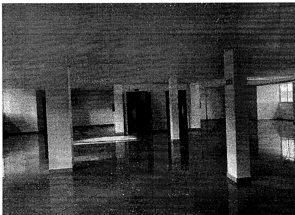
Vista das portas de acesso ao pavimento superior o qual compreendem as salas comerciais 03 e 04. (Fonte: Autor, 2022).
