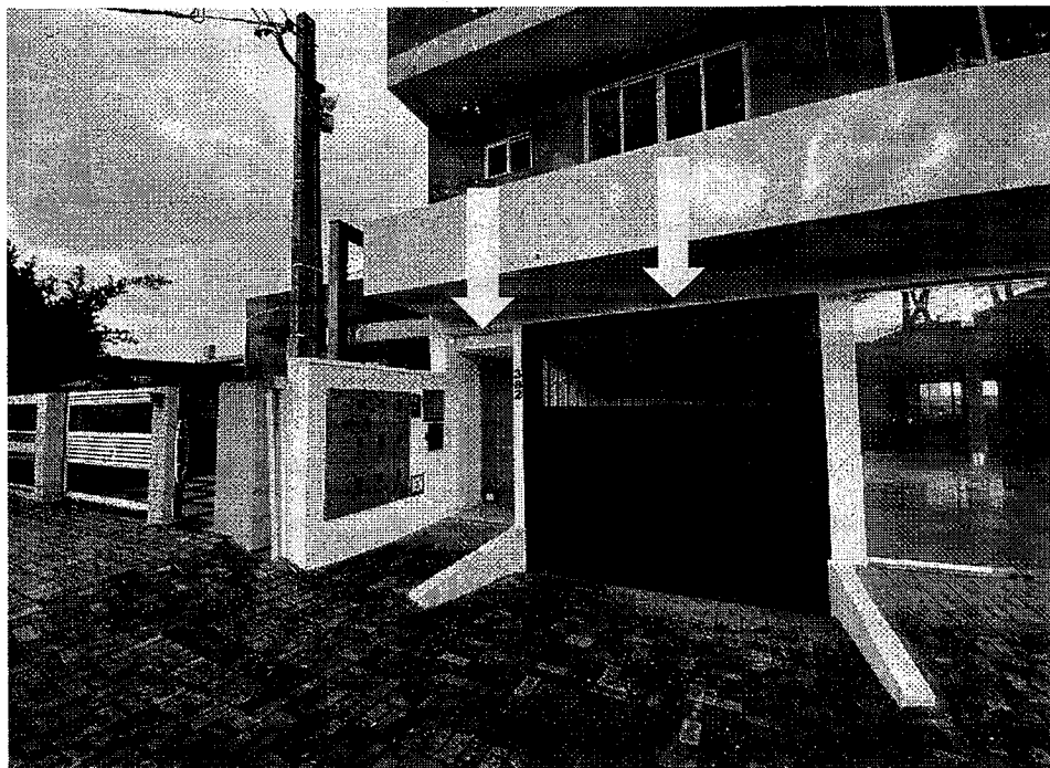
Vista do acesso a salas comerciais e garagem. (Fonte: Autor, 2022).
