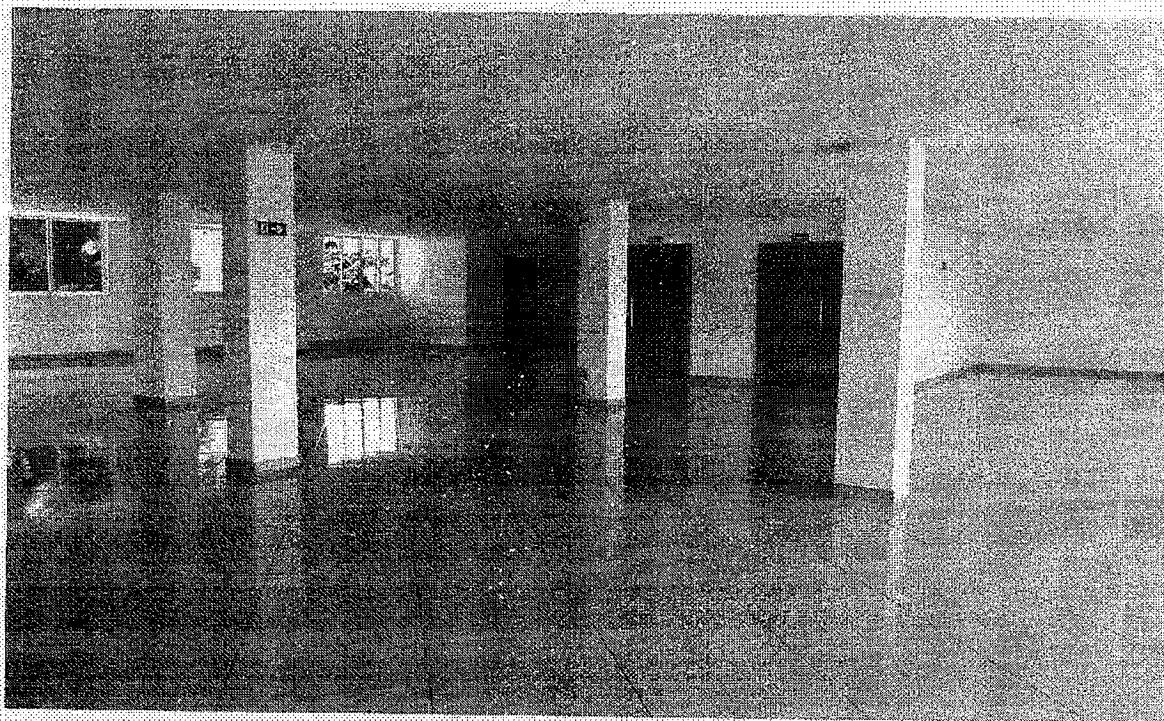
Figura 8: Fotografia do interior da sala primeiro andar
