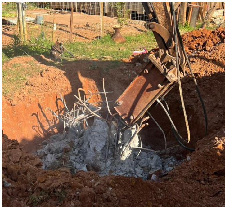
Figura 31 – Processo de remoção das fundações encontradas
