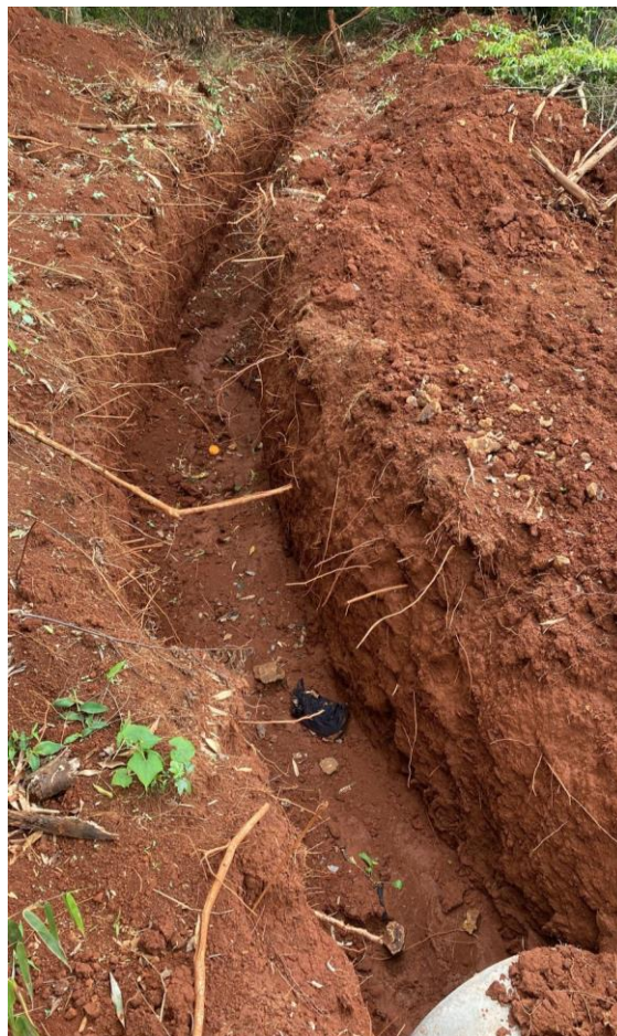
Figura 09 – Vala de drenagem realizada além do dissipador na Rua Nelson Rotta
