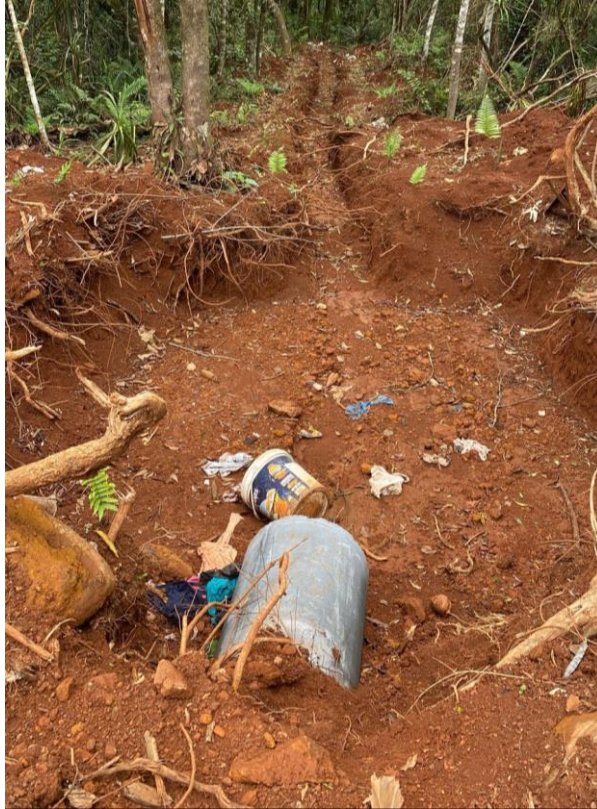
Figura 06 – Vala de drenagem realizada além do dissipador na Rua Flori de Souza
