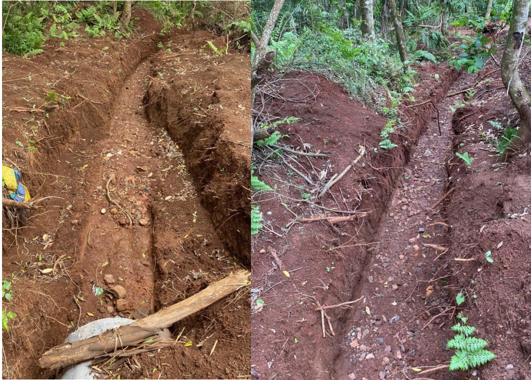
Figura 08 – Vala de drenagem realizada além do dissipador na Rua Mateus Cavilha
