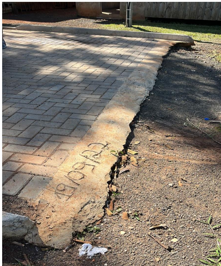
Figura 35 – Viga de travamento
