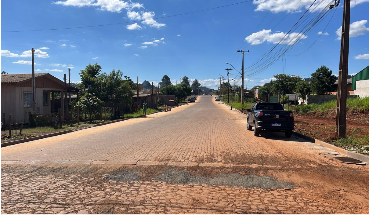
Figura 36 – Viga de travamento com meio fio deitado
