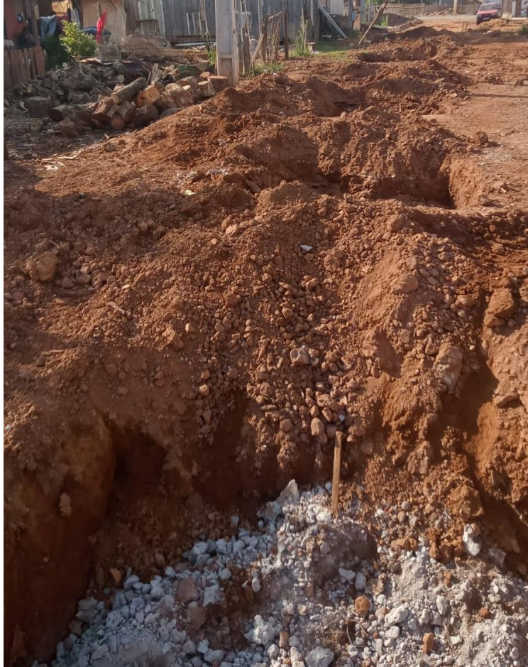
Figura 32 – Processo de remoção das fundações encontradas sendo finalizado
