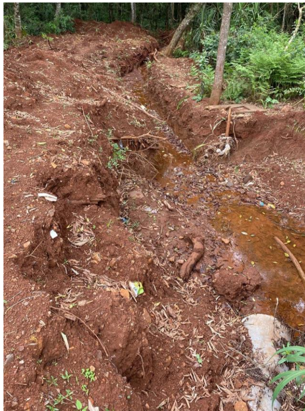
Figura 07 – Vala de drenagem realizada além do dissipador na Rua Genor Comin
