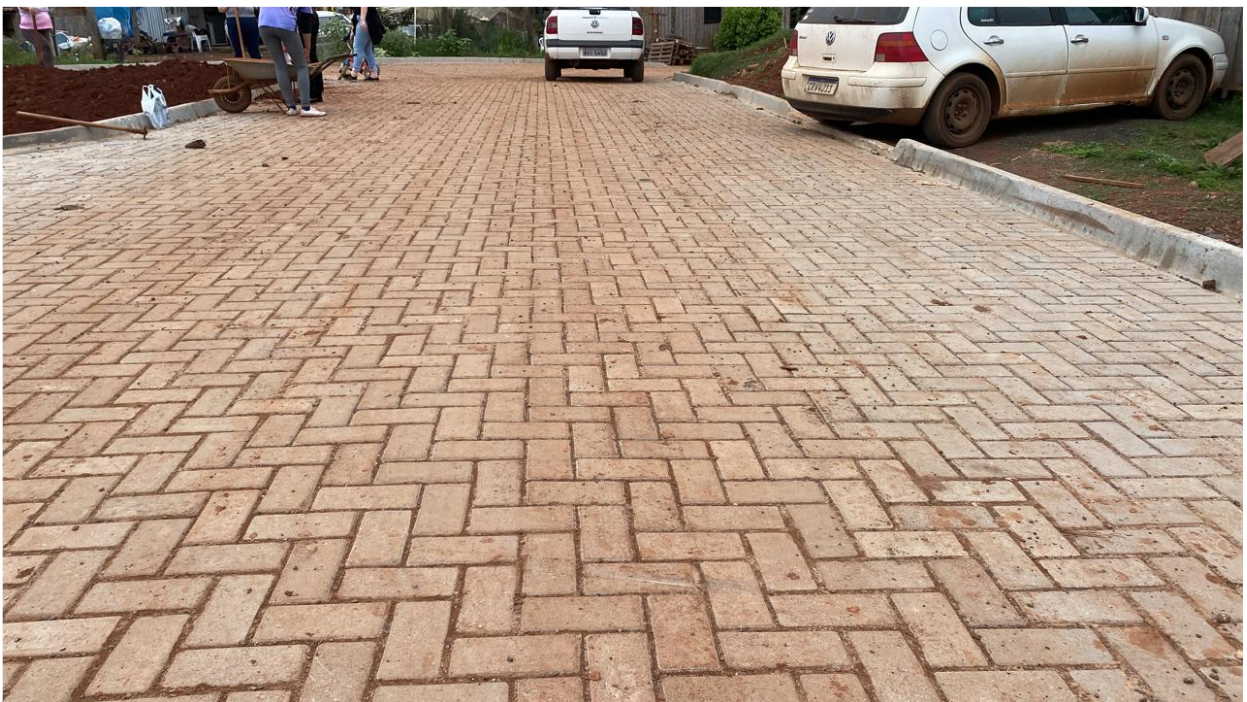
Figura 04 – Execução da extensão realizada na Rua Cleci Salete Maioli
