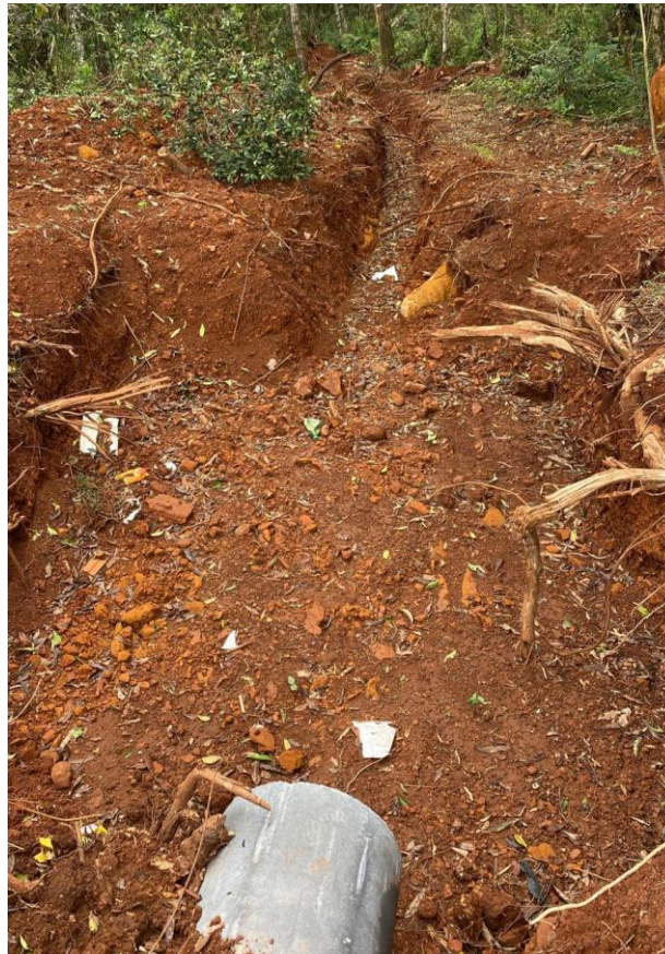
Figura 05 – Vala de drenagem realizada além do dissipador na Rua Antônio Velocindo Gross
