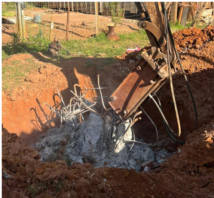
Figura 31 – Processo de remoção das fundações encontradas
