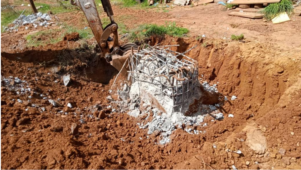
Figura 30 – Fundações encontradas durante a execução
