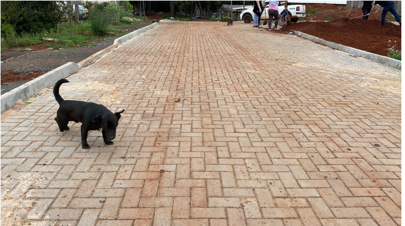
Figura 03 – Execução da extensão citada na Rua Adalmiro Nesi
