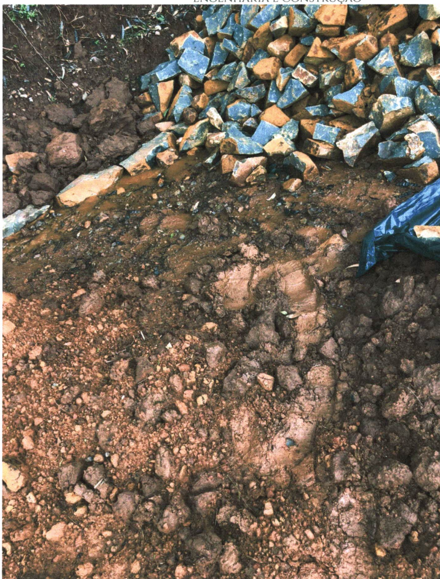
Imagem 08: Umidade causada pela chuva e vertentes
