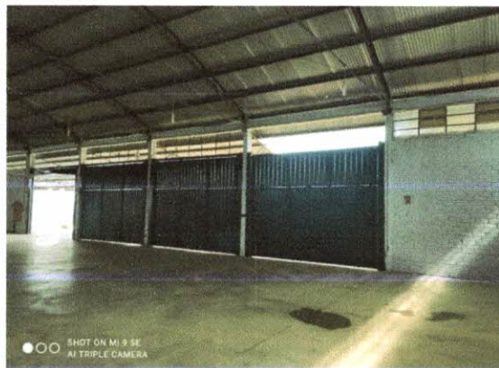
Portão carga e descarga, Barracão 1000m 2
