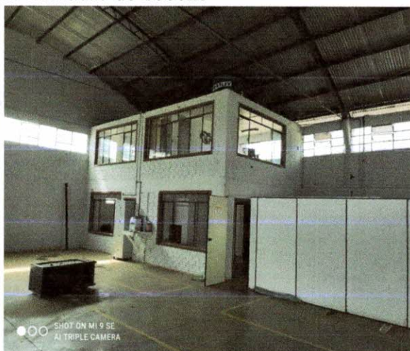
Construção interna Barracão 80m 2 , escritório
