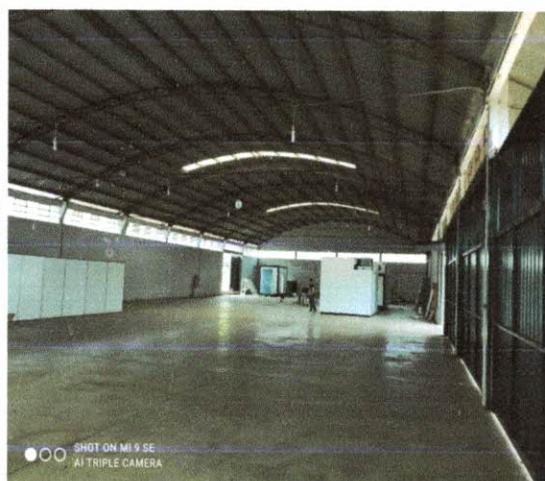
Visão interna e estrutura e cobertura.
