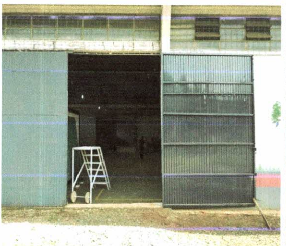
Portão de acesso lateral Barracão 1000m 2
