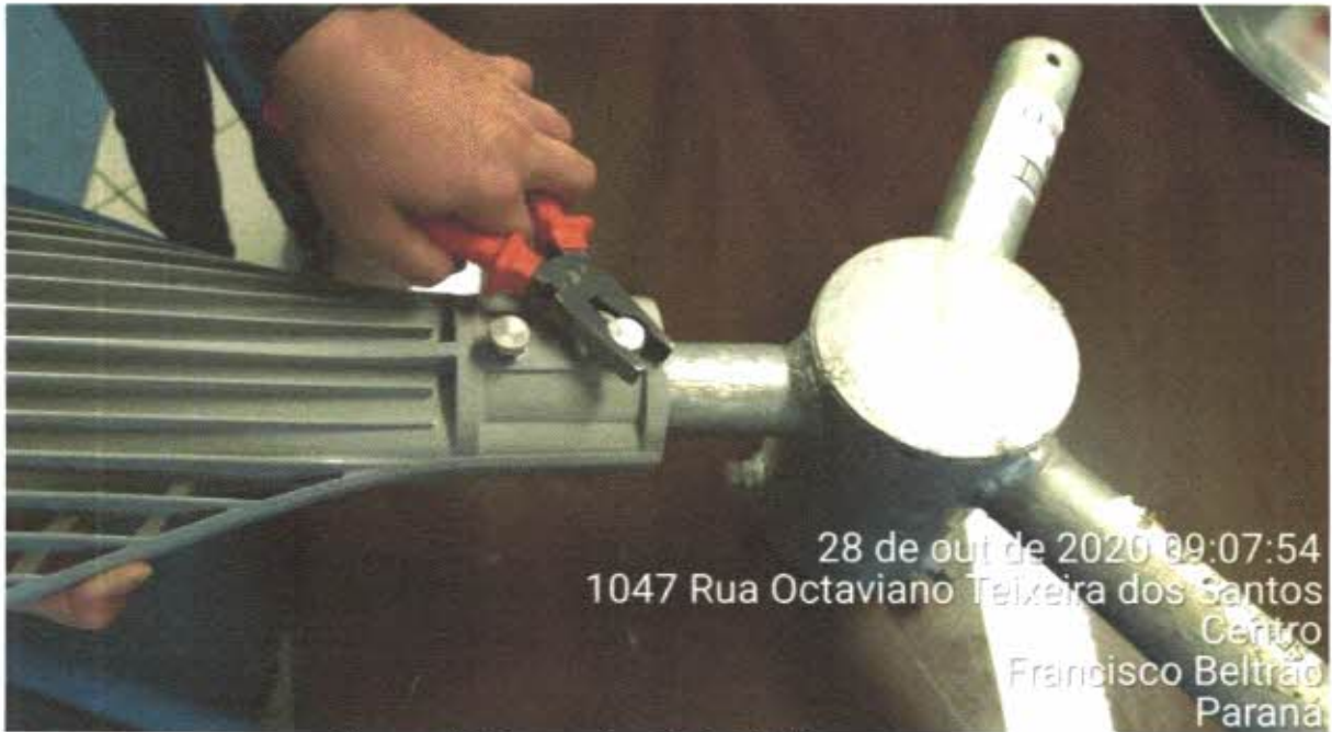
Fotografia 3 – encaixe da luminária no suporte.
