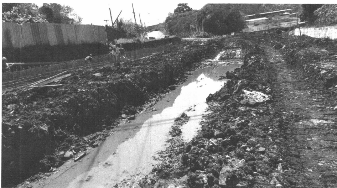
Foto 08: Terreno após execução de limpeza de material excedente - Rua Perú.
