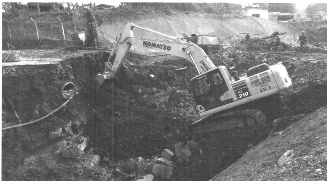
Foto 01: Serviço de escavação na Rua Venezuela
