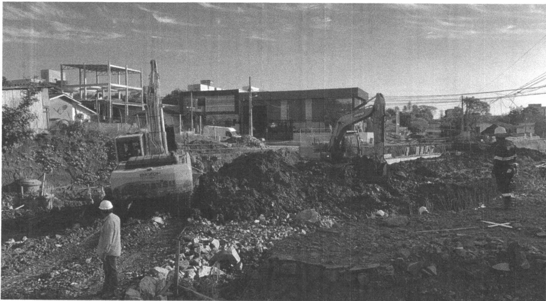
Foto 06: Remoção de material excedente - Rua Perú - Após conclusão de estacas.
