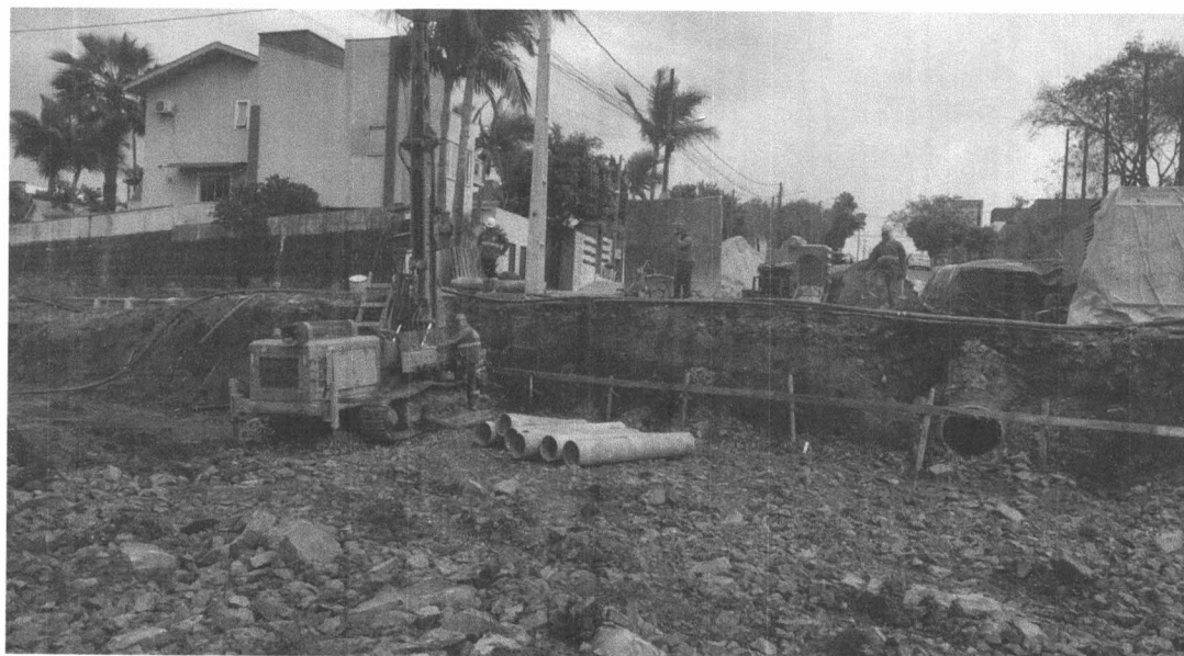
Foto 02: Serviço de embasamento realizado na Rua Venezuela
