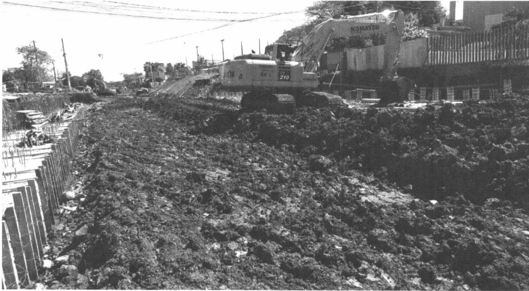
Foto 05: Remoção de material excedente - Rua Perú - Após conclusão de estacas.
