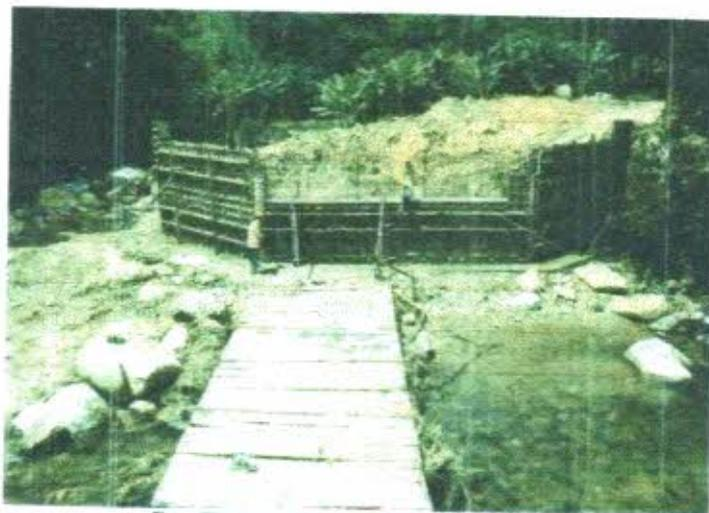
Foto 09: Armação e forma das alas montadas
