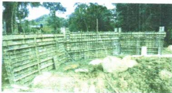
Foto 10: Armação e forma das alas montadas
