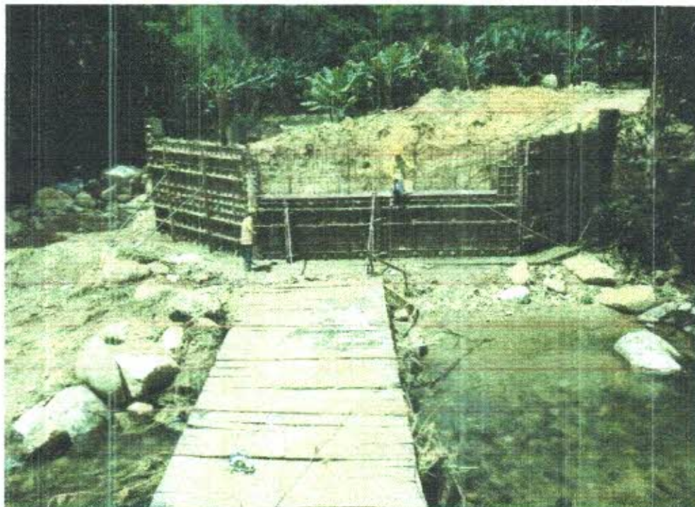
Foto 09: Armação e forma das alas montadas
