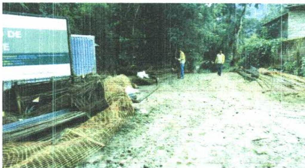
Foto 08: Aço de toda obra a entregue
