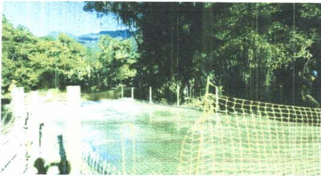
Foto 22: Concretagem da ponte finalizada
