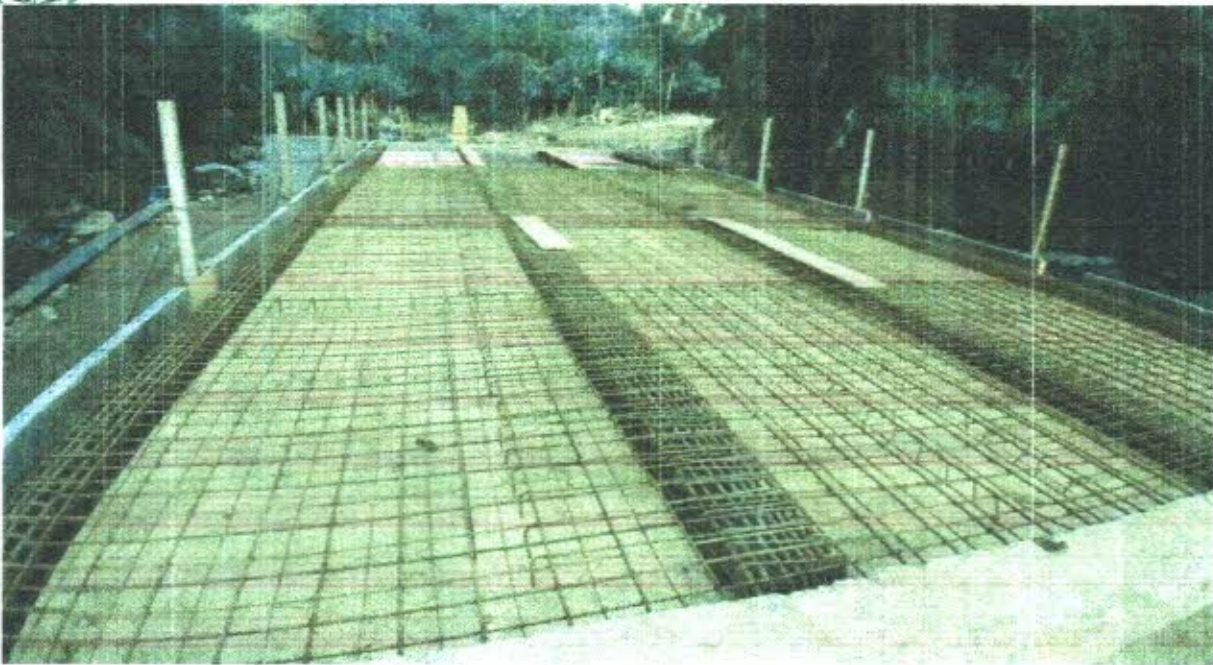
Foto 19: Laje armada pronta para concretagem
