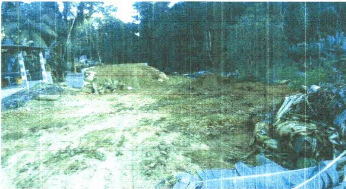
Foto 20: Reaterro das cabeceiras e alas da ponte
