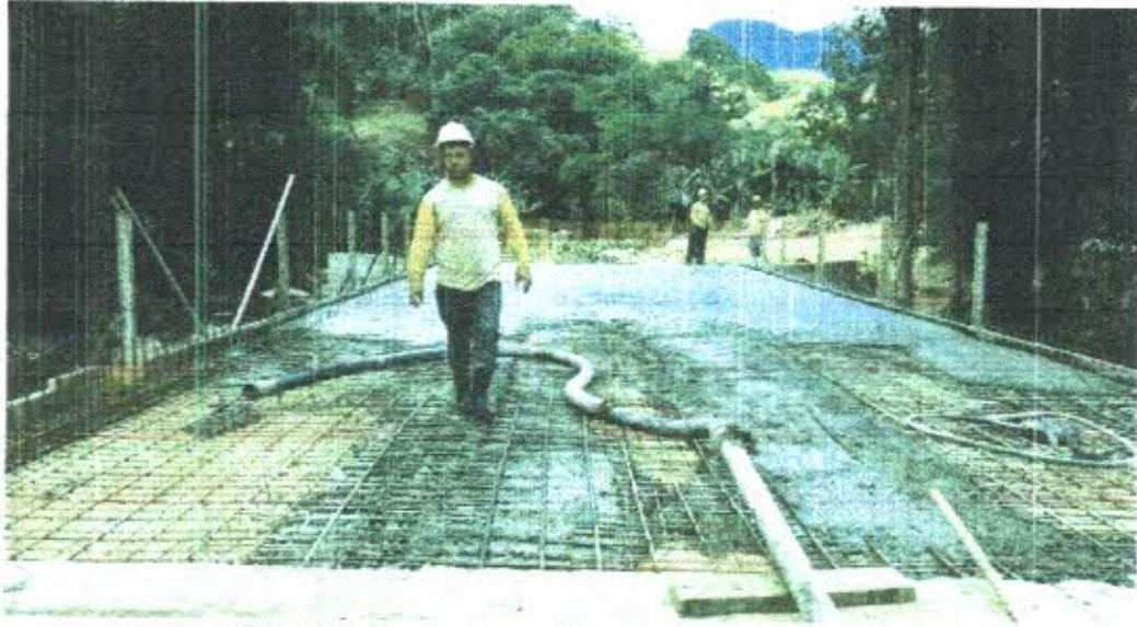
Foto 21: Concretagem da ponte sendo realizada
