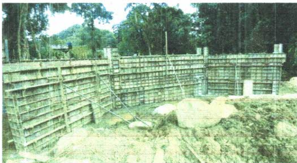
Foto 10: Armação e forma das alas montadas
