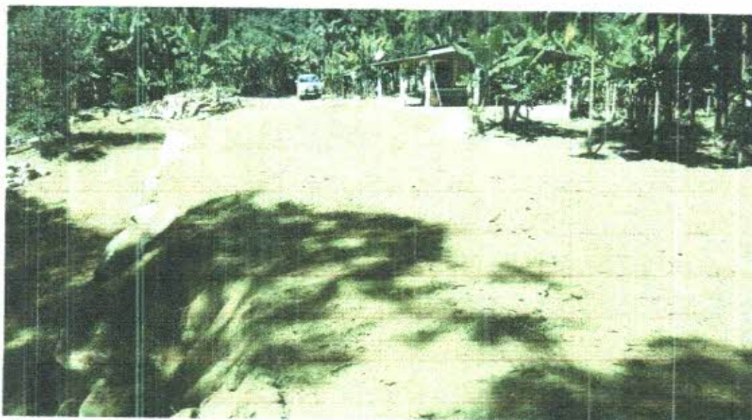
Foto 25: Reaterro nas cabeceiras finalizado
