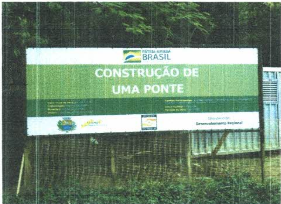
Foto 03: Instalação da placa de obra
