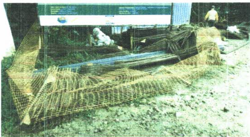
Foto 06: Aço de toda obra a entregue
