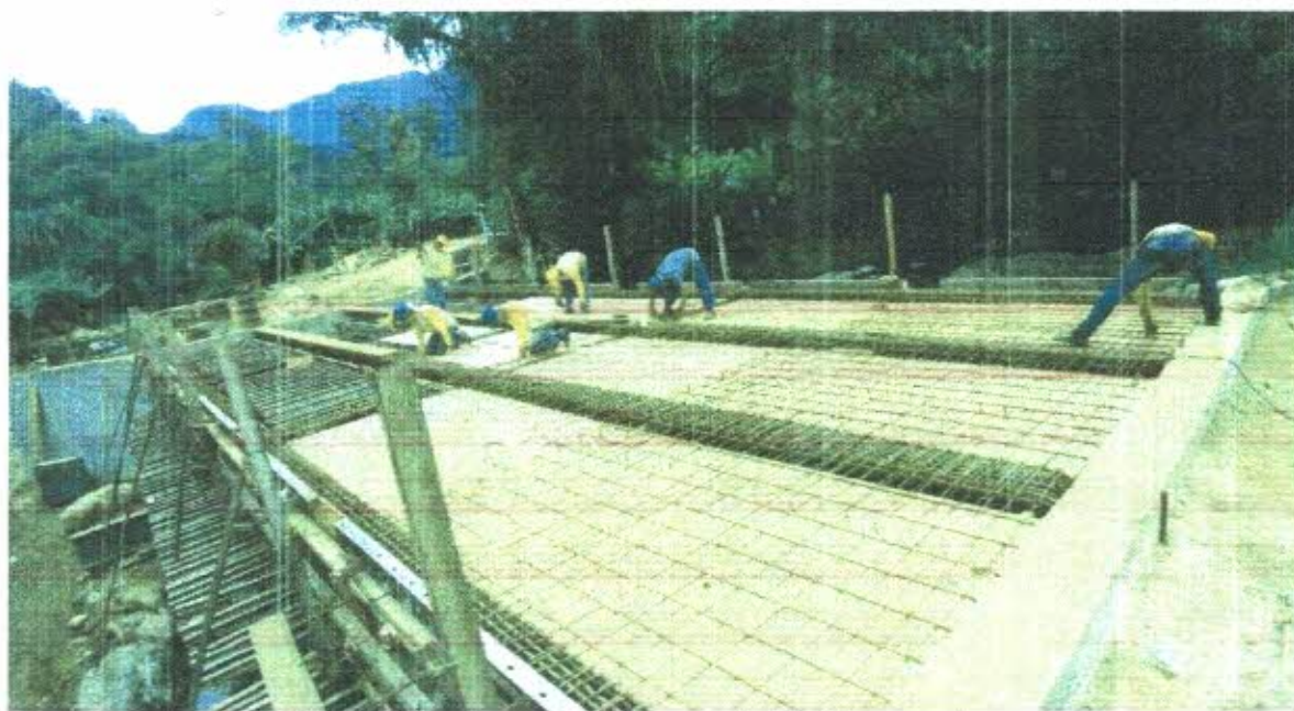
Foto 18: Montagem das formas e início das armaduras
