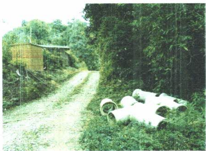
Foto 04: Implantação do canteiro de obra
