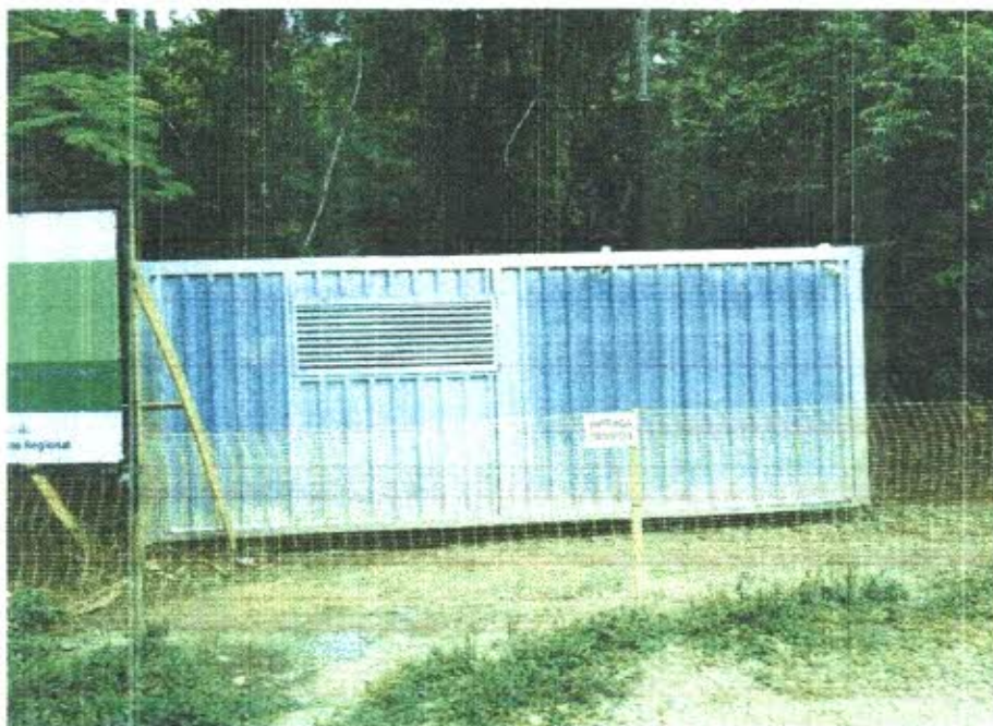
Foto 05: Instalação e implantação de Container
