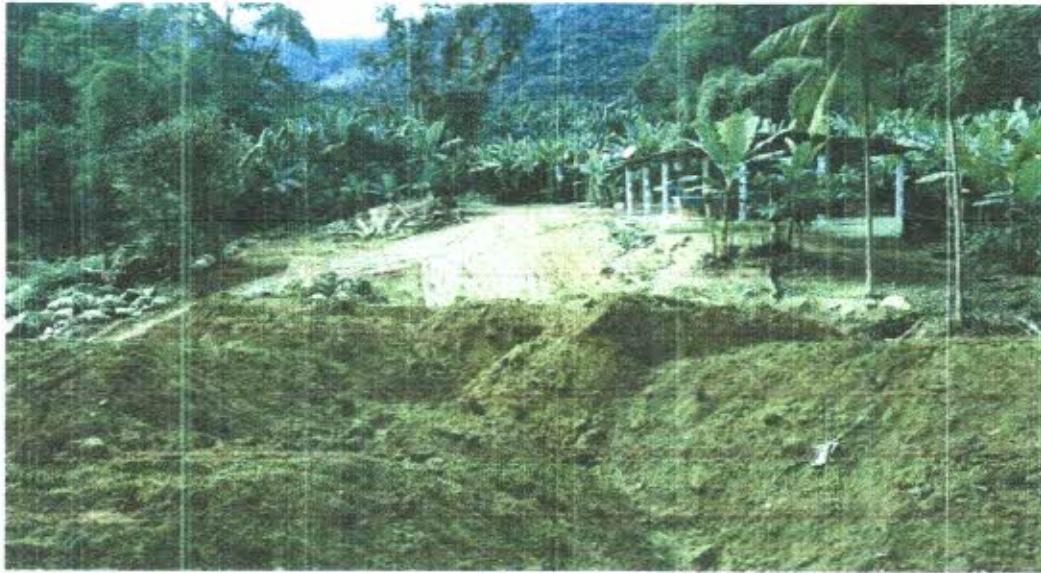
Foto 23: Reaterro nas cabeceiras sendo realizado
