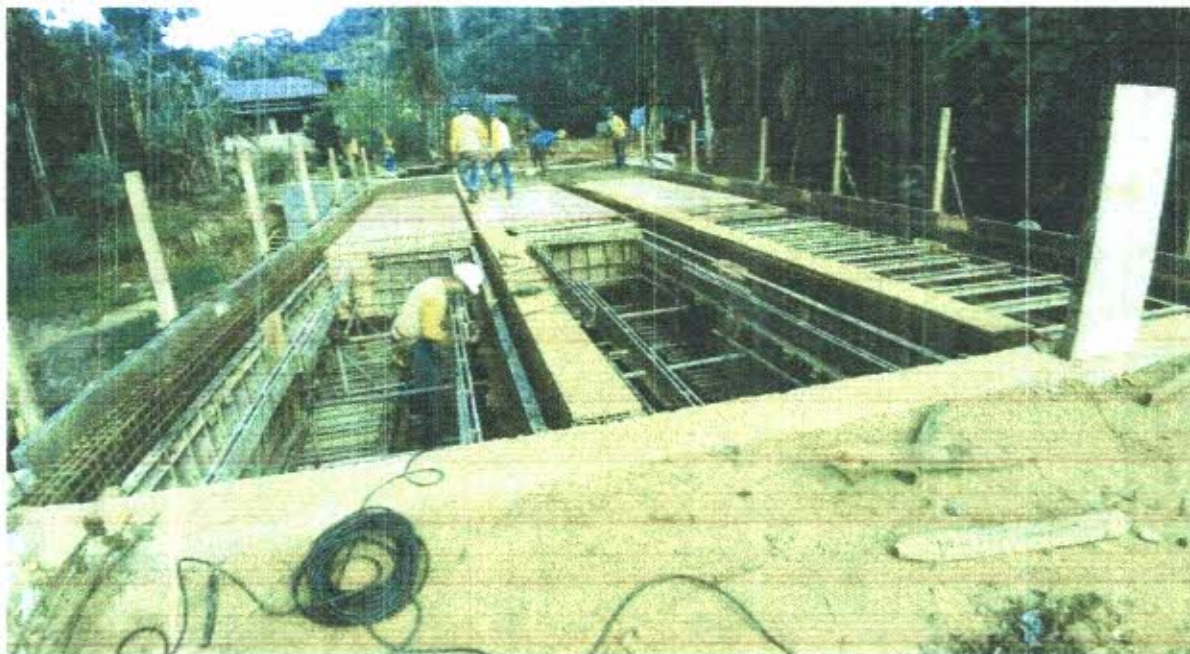
Foto 17: Montagem dos escoramentos e formas
