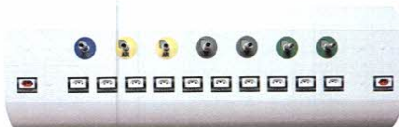
Imagem 58: Painel de gases medicinais em alumínio extrudado.
