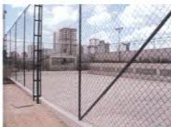
Imagem 60: Alambrado sobre mureta de concreto.
