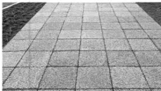
Imagem 61: Calçada em blocos drenantes em concreto.
