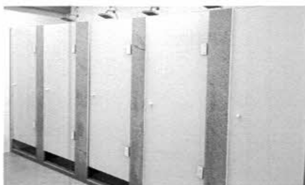
Imagem 20: Portas em vidro temperado liso serigrafado na cor branco.
