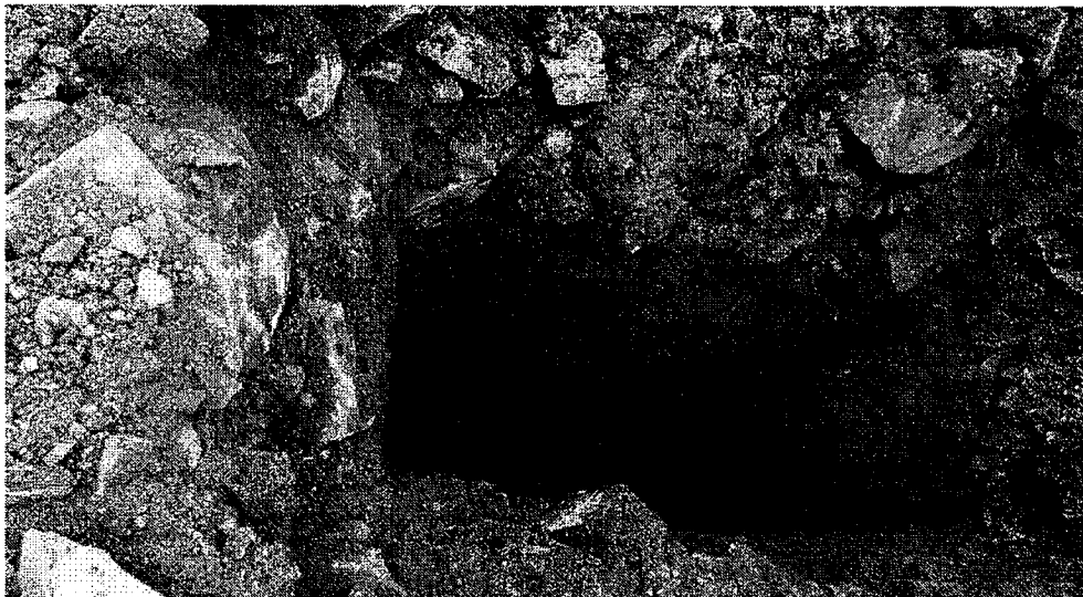
Imagem 01: Escavação de verificação.
