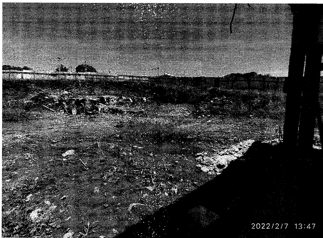
Imagem 01: Área onde se faz necessária a conclusão do desmonte de rocha para possibilitar o início da construção dos quatro blocos restantes.
