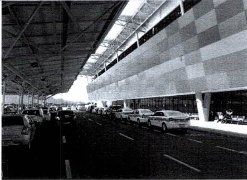
Foto 3: TPS – Vista do Lado Terra / meio fio
