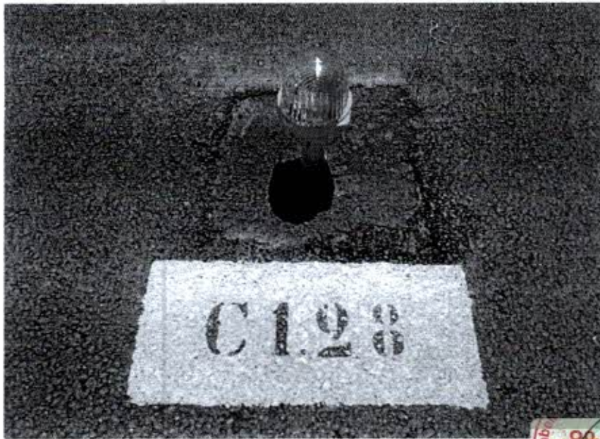
Foto 30: Luminária de balizamento da PPD 02-20
