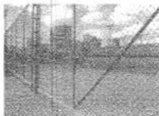
Imagem 60: Alambrado sobre mureta de concreto.
