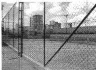
Imagem 60: Alambrado sobre mureta de concreto.
