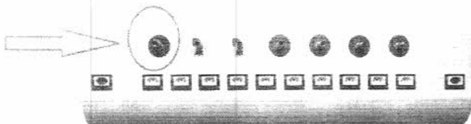
Imagem 58: Painel de gases medicinais em alumínio extrudado.
