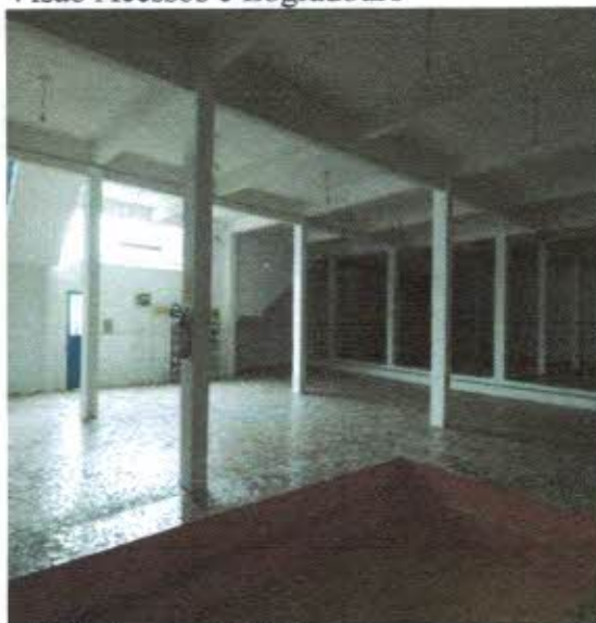
Visão interna da Sala
