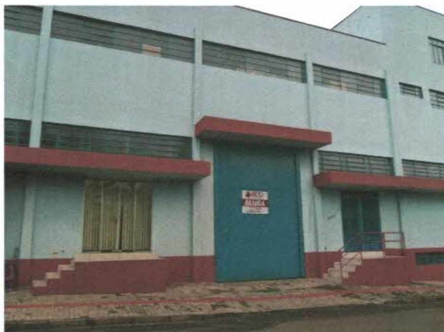
Figura 3: Fotografia da frente da sala
