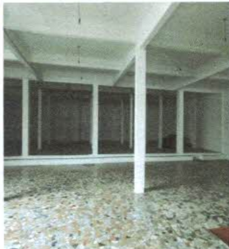
Visão interna da sala
