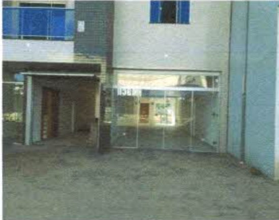
Visão de acesso e entrada sala 80m 2
