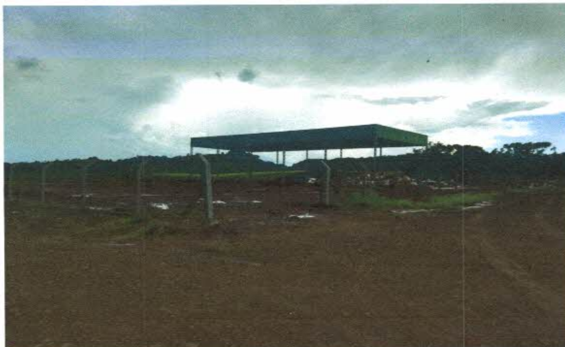
Estrutura metálica coberta de aproximadamente 250m 2 e acesso.
