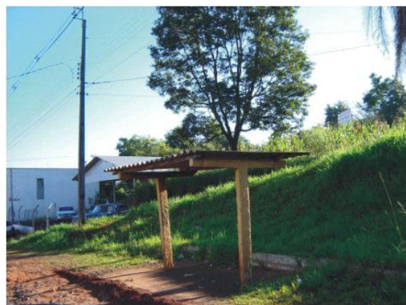
ABRIGO - COBERTURA EM CHAPA DE AMIANTO
