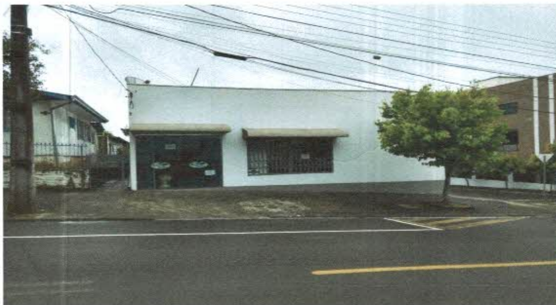
Visão frente sala e acesso pela Rua Antônio Carneiro Neto.
