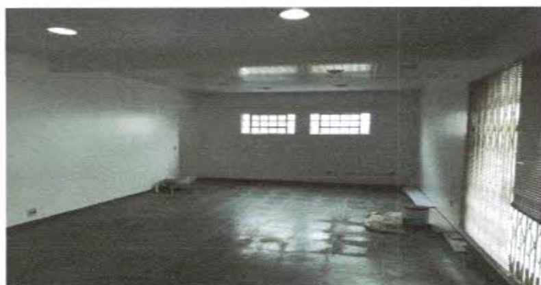
Interior da sala
