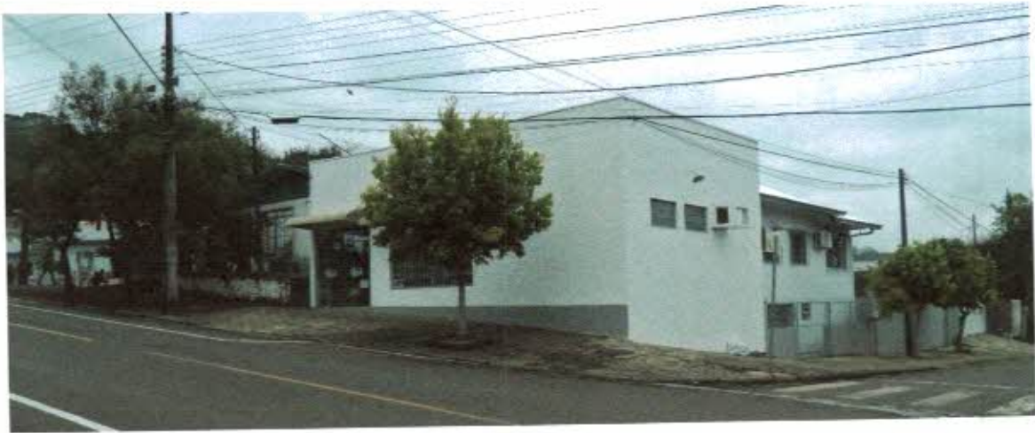
Figura 8: Foto lateral com frente para Rua Emílio Donatti.
