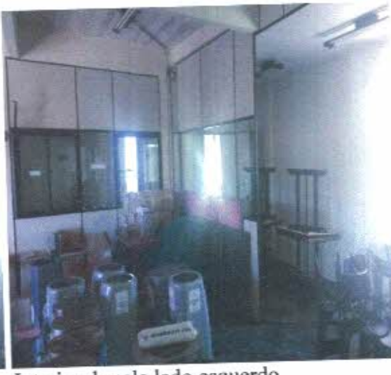
Interior da sala lado esquerdo
