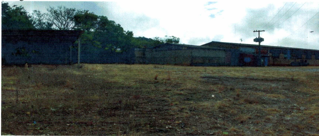
Visão extensão da frente do lote com os barracões .
