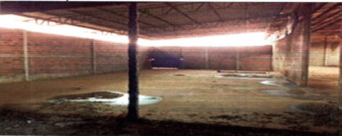
Visão interna do segundo barracão.
