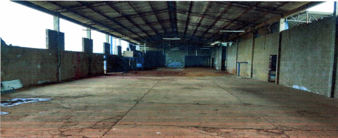
Visão interna do primeiro barracão.
