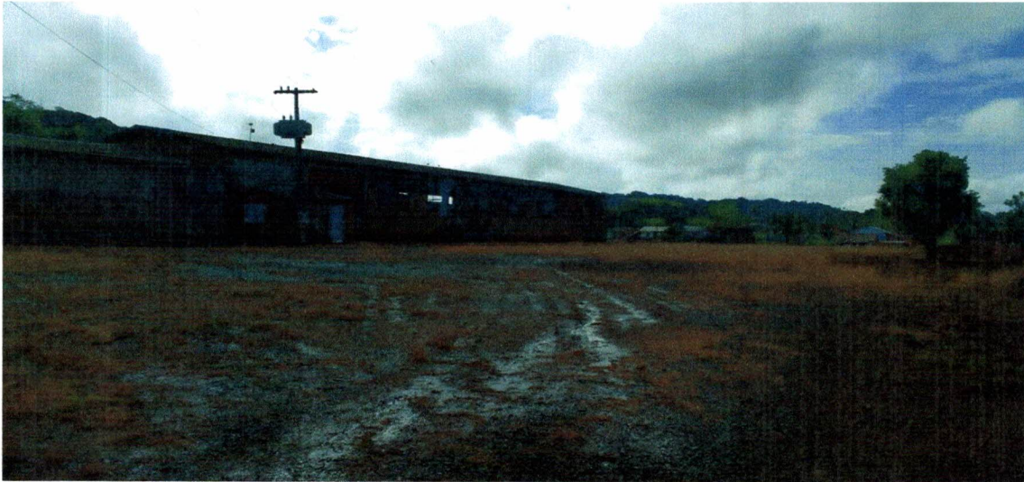
Frente do terreno e acesso.
