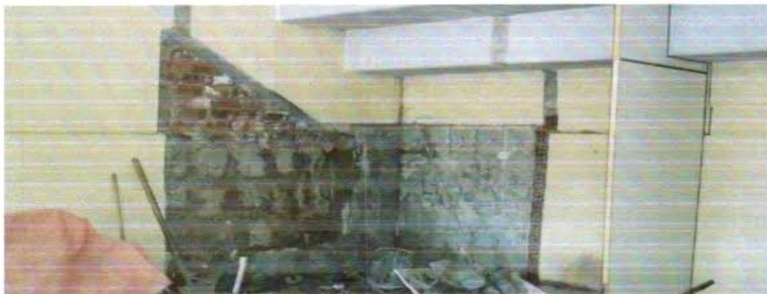
Espaço em construção dos banheiros.
