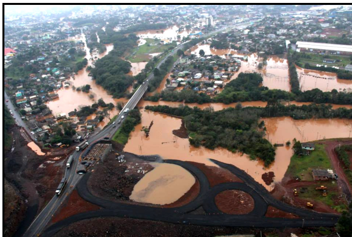
FOTO 02 – Parte da trincheira que está sendo construído – Bairro São Miguel e Marrecas – Enchente de 28/06/2014.
